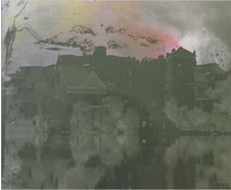
Obr. 1 Aplikace lazurové retuše v horní části negativu
