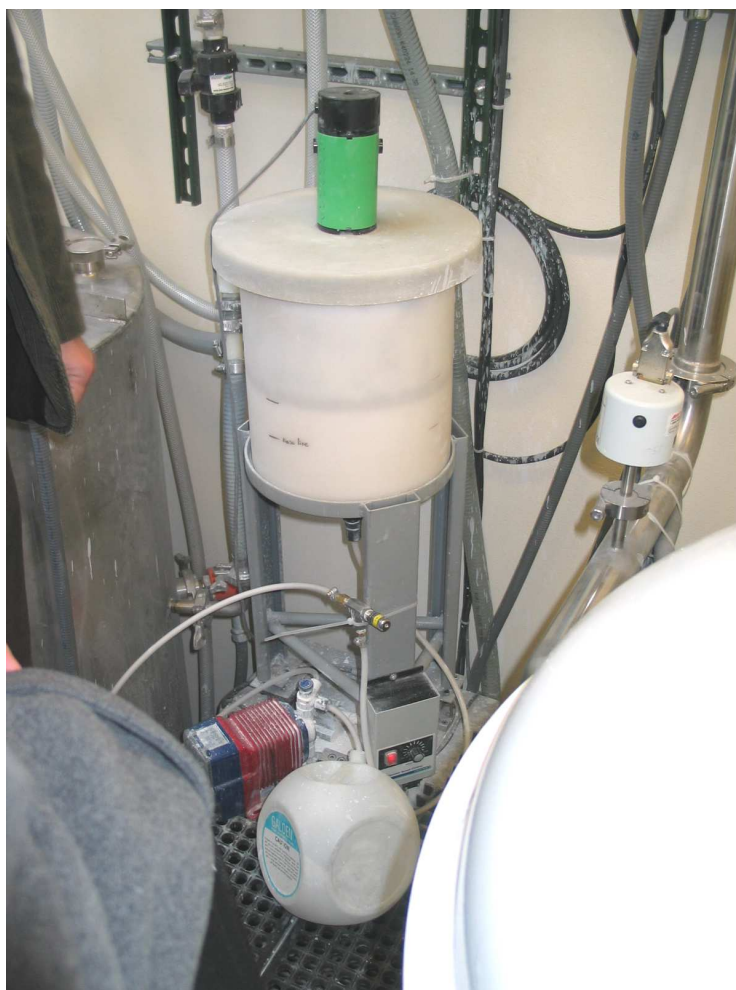
Obr. 16 Zásobník koncentrátu odkyselovací roztoku Jagellonská univerzitní knihovna v Krakově
