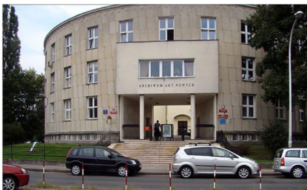
Budova Archiwu Akt Nowych.
