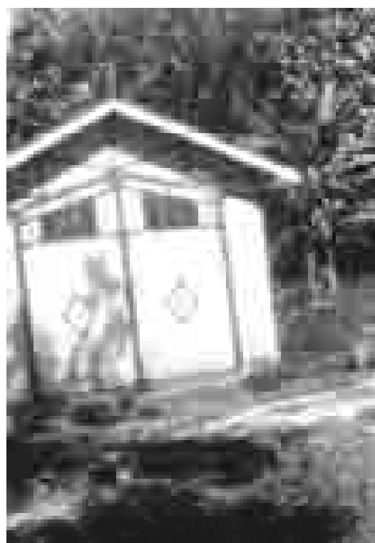
Nejlepší domek v Taiohae – ocelová konstruk- ce, stěny everitové
