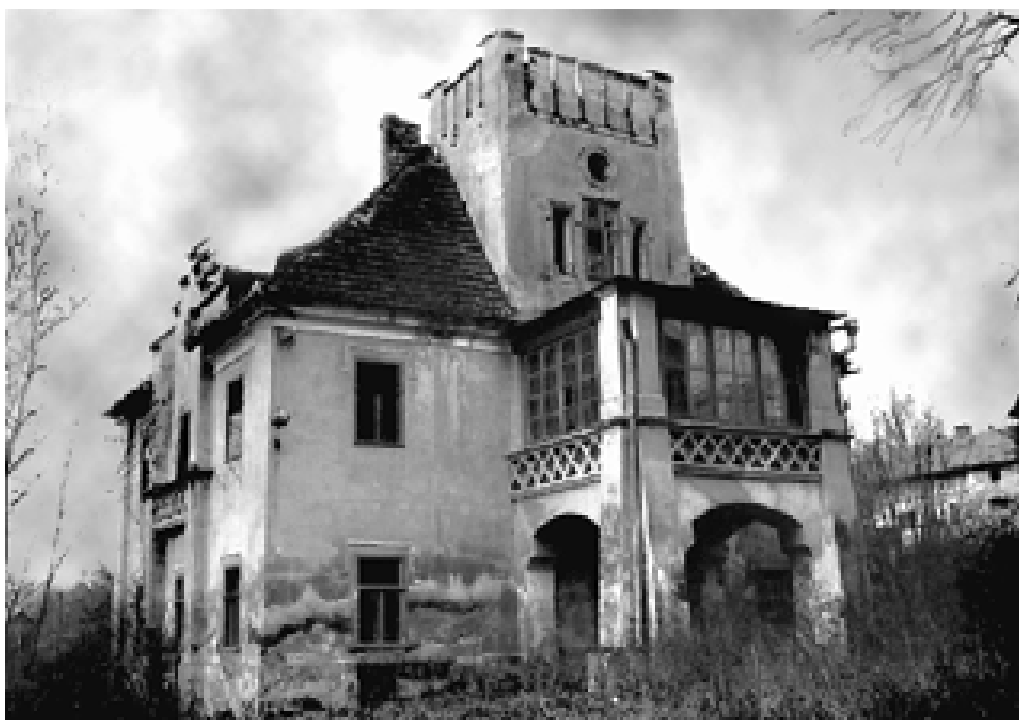
Obr. 10: Kojšice, zámek od jihovýchodu roku 1986 (foto autor)
